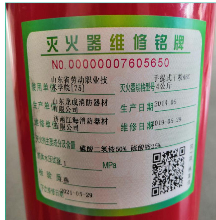
灭火器维修铭牌
